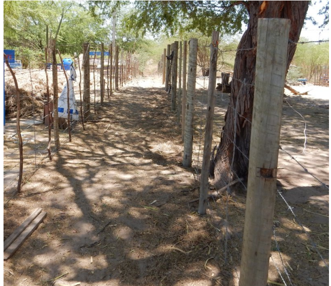
Vorbereiteter Laufweg der Ziegen vom Standort des Stalls in Richtung Riacho, damit die Ziegen den übrigen Anbau auf dem Gelände nicht stören.
